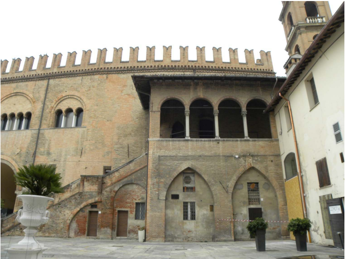
Vista attuale della loggia
